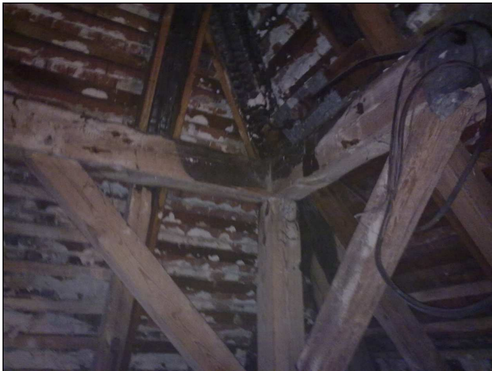
KROKIEW NAROŻNA, KROKIEWIE DACHOWE, PŁATWIE
