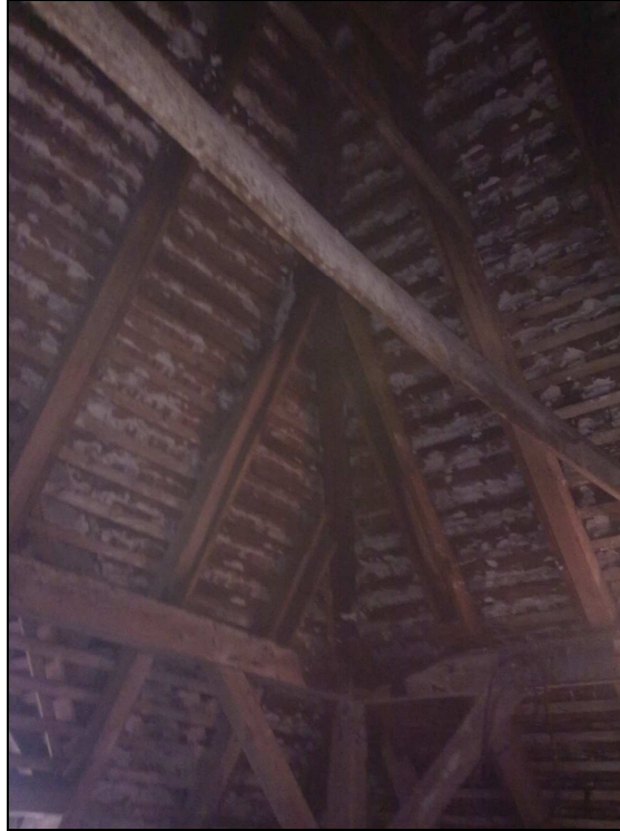
KROKIEW NAROŻNA, KROKIEWIE DACHOWE, PŁATWIE
