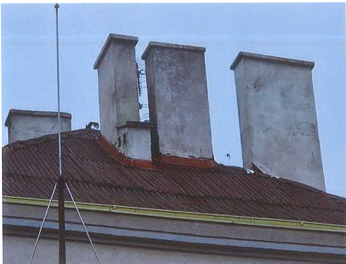
Zdj. nr 7. Dach, kominy od strony ul. Kasztelańskiej.
