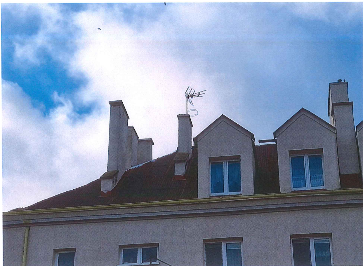
Zdj. nr 5. Dach - widok od strony ul. Rybnickiej.
