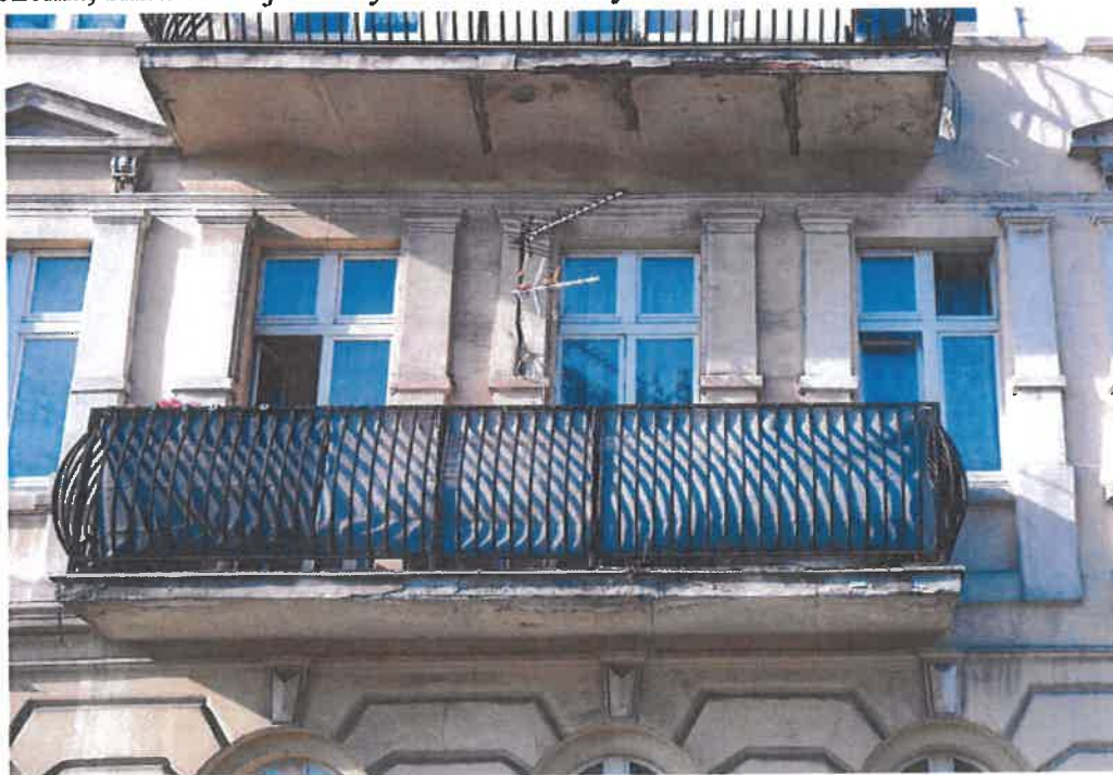
Zdj. nr 12. Widoczne uszkodzenia gzymsów, nadproży okiennych. Zacieki pod płytą balkonu, silna korozja belek.
