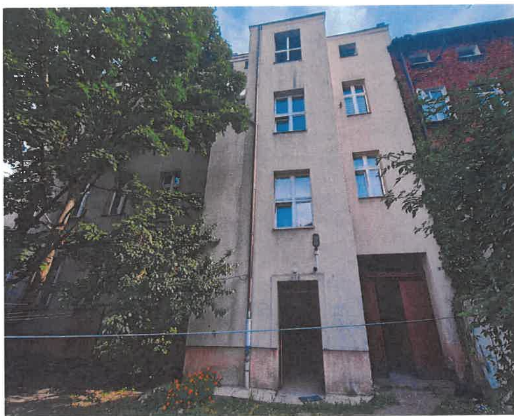
Zdj. nr 3. Elewacja budynku od strony podwórza.
