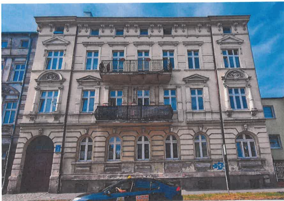
Zdj. nr 1. Elewacja frontowa budynku kamienicy.
