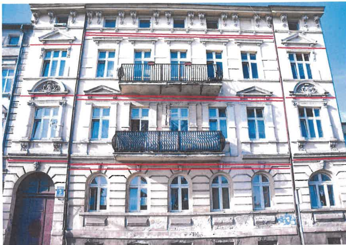
Zdj. nr 14. Przystawiono miejsca wykonania bruzdy o głębokości 50mm w celu wykonania podwójnego zbrojenia o średnicy \varnothing 10\text{mm} dla wzmocnienia przeciężonych ścian.
