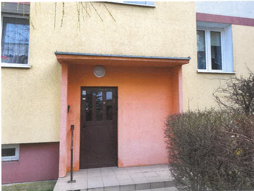
Zdj.2. Przykładowe wejście do budynku.
