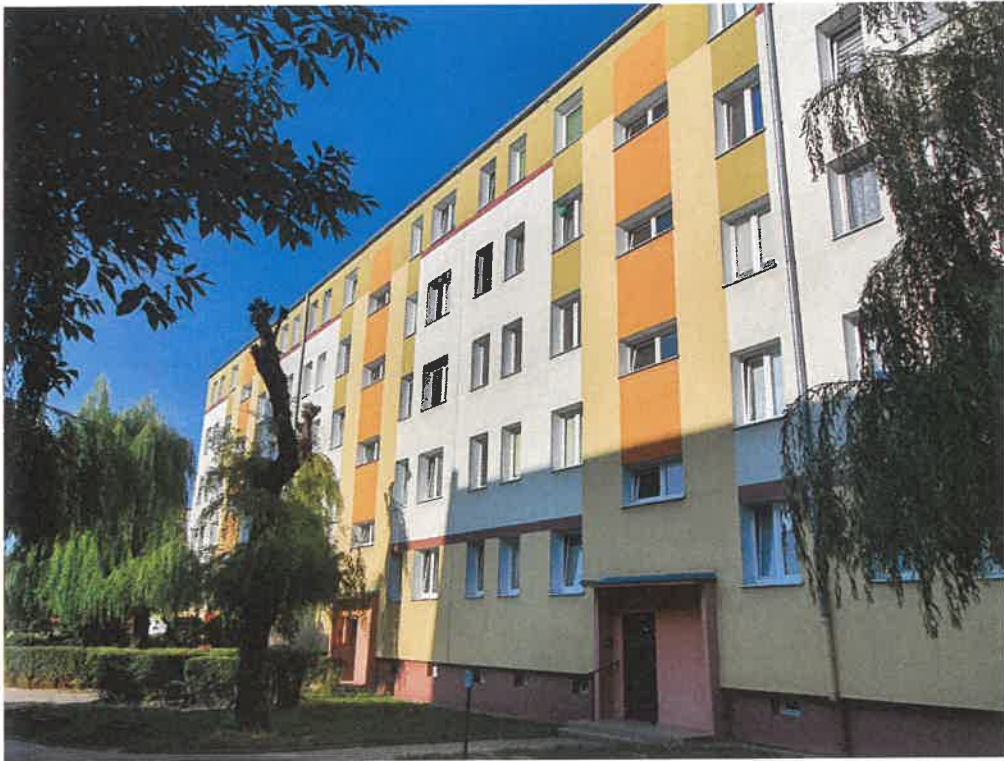
Zdj.1. Widoczna ściana zachodnia z wejściami do budynku.
