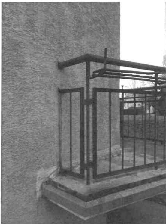
Wtopienie istniejącej balustrady w docieplenie ścian zewnętrznych
