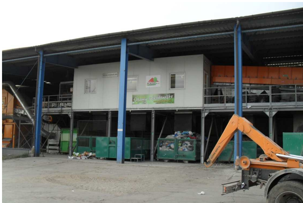
Fot. 5. Hala nr 5 do obróbki odpadów zmieszanych cz 2.
