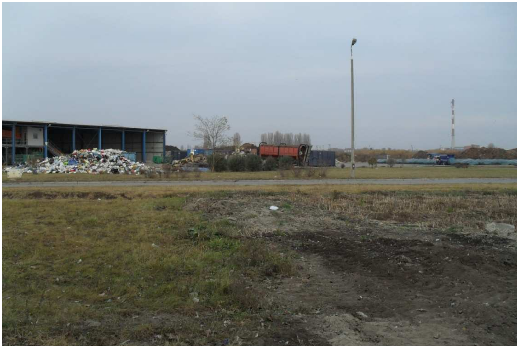
Fot. 2. Widok na halę nr 5, plac kontenerowy KNEER i miejsce lokalizacji hali nr 6.
