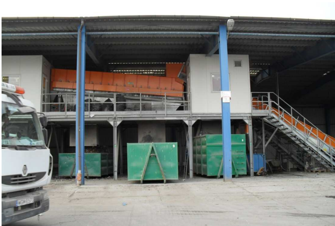
Fot. 4. Hala nr 5 do obróbki odpadów zmieszanych cz 1.
