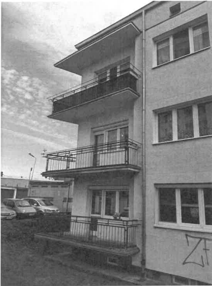
Narożnik północno-zachodni budynku
