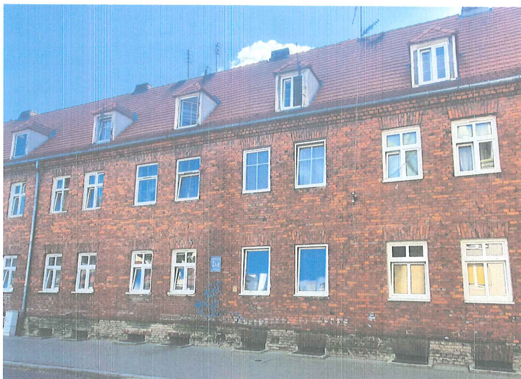
Zdj.2. Elewacje frontowe budynku, segment B.
