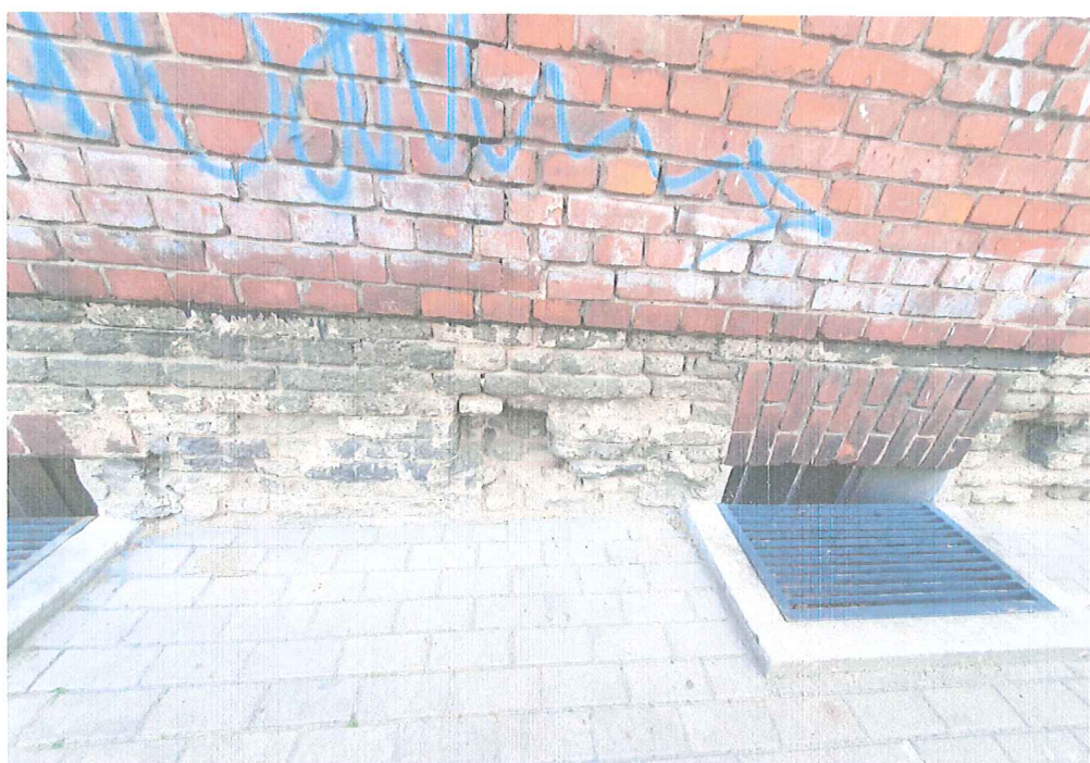
Zdj. 7. Widoczne rozwarstwienie muru w miejscu połączenia segmentów budynku, od strony frontowej budynku.
