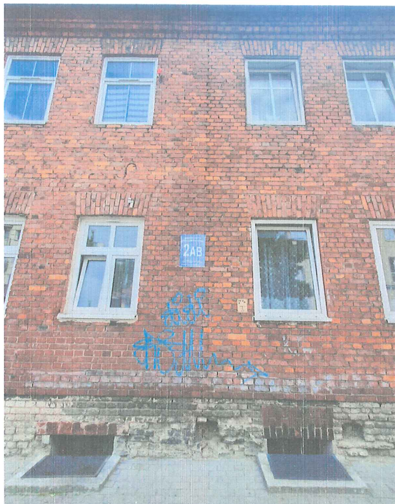
Zdj. 7. Widoczne rozwarstwienie muru w miejscu połączenia segmentów budynku, od strony frontowej budynku.
