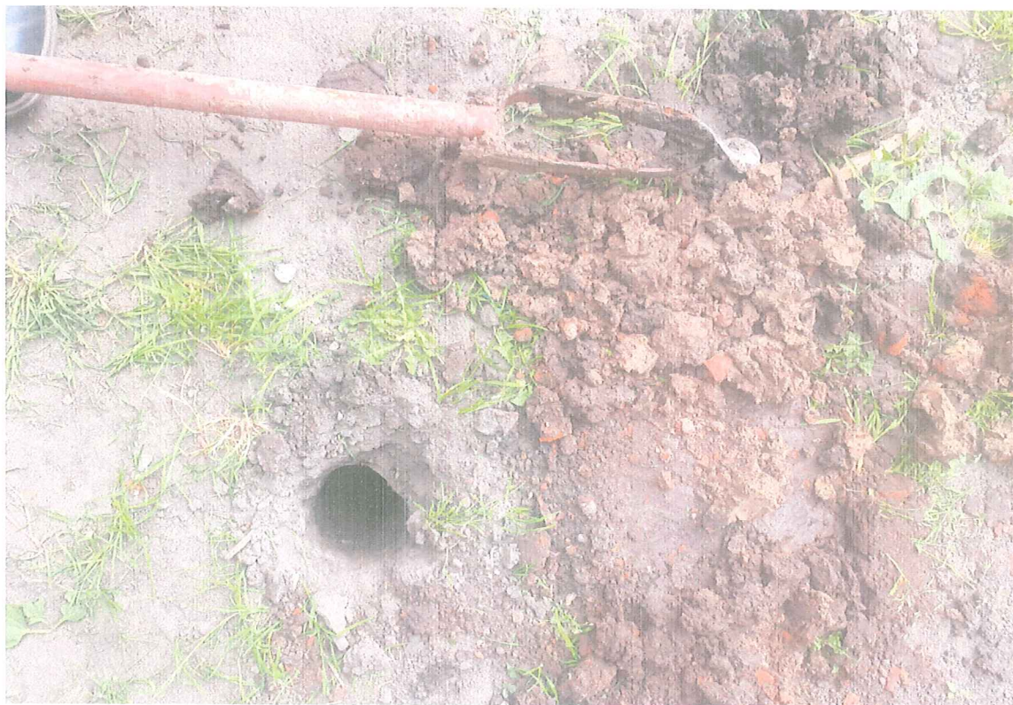
Zdj.16. Widoczne warstwy gruntu z otworu wiertniczego – w tym glina piaszczysta z poziomu posadowienia budynku.
