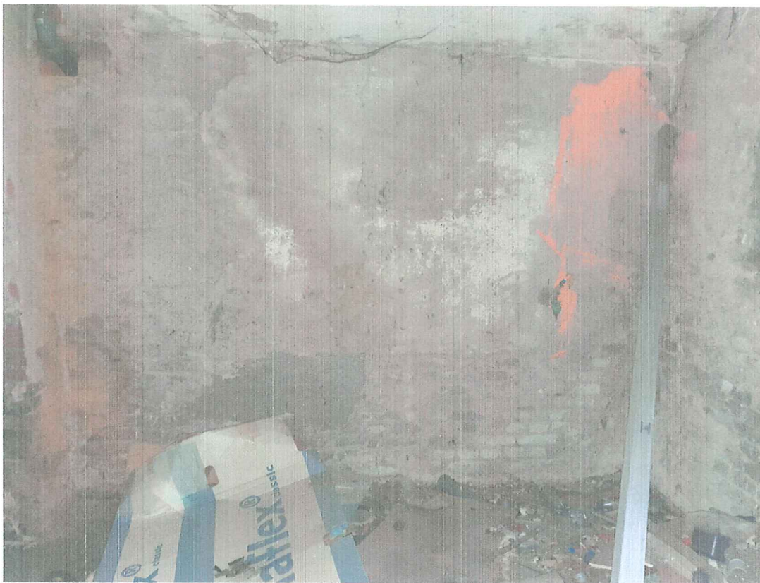
Zdj.10. Mur w piwnicy pomiędzy segmentem A i B.
