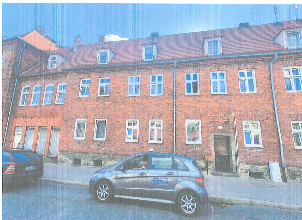
Zdj.3. Elewacje frontowe budynku, segment B.
