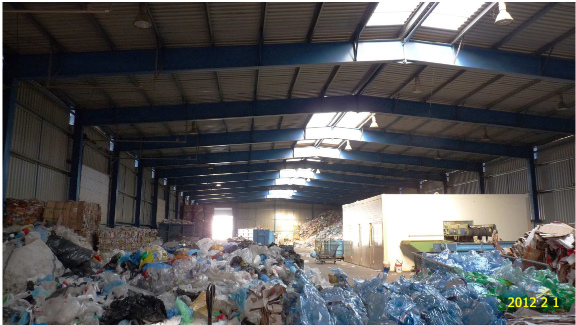
Fot. 1 Widok budynku
