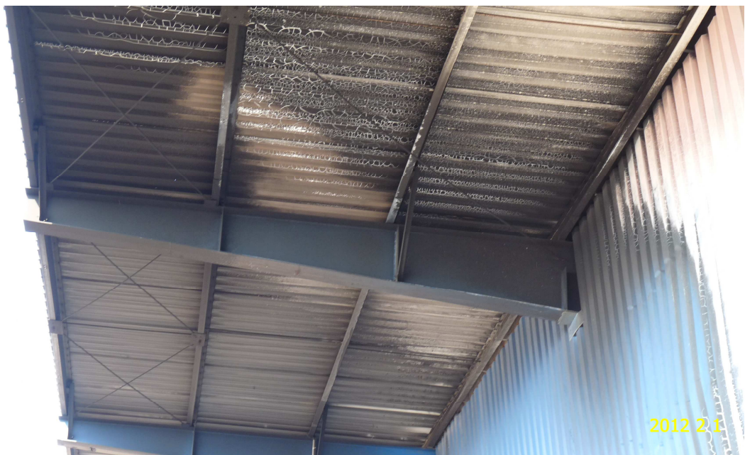
Fot. 6 Widok zadaszenia wspornikowego w miejscu powstania pożaru
