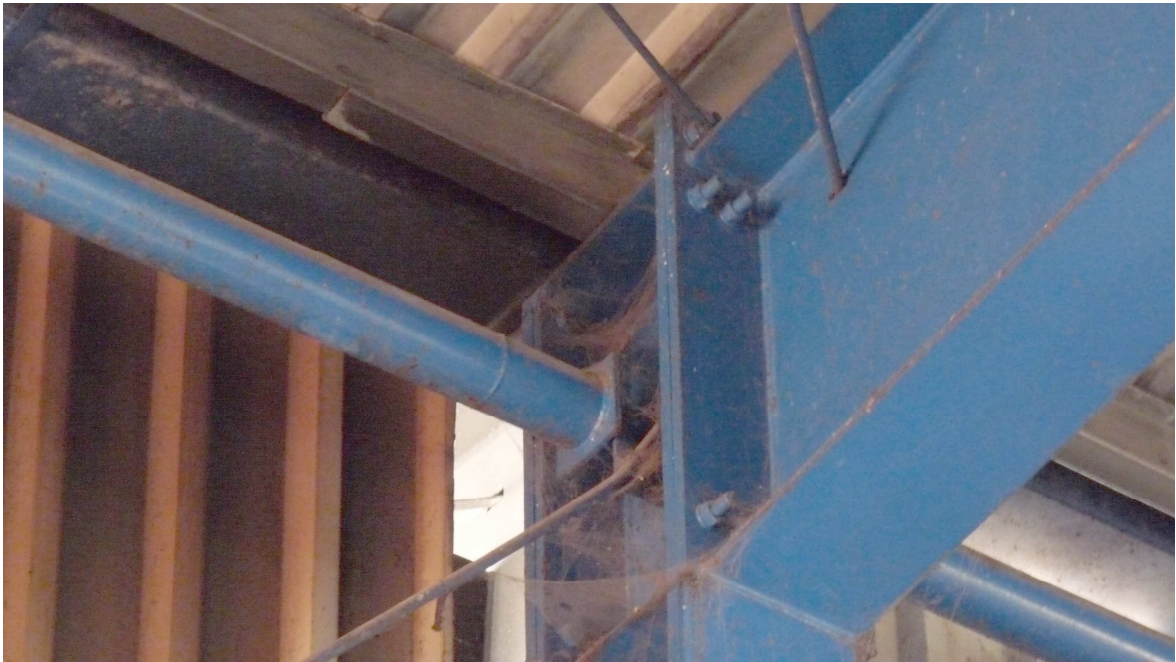
Fot. 5 Połączenie rygla dachowego z słupem
