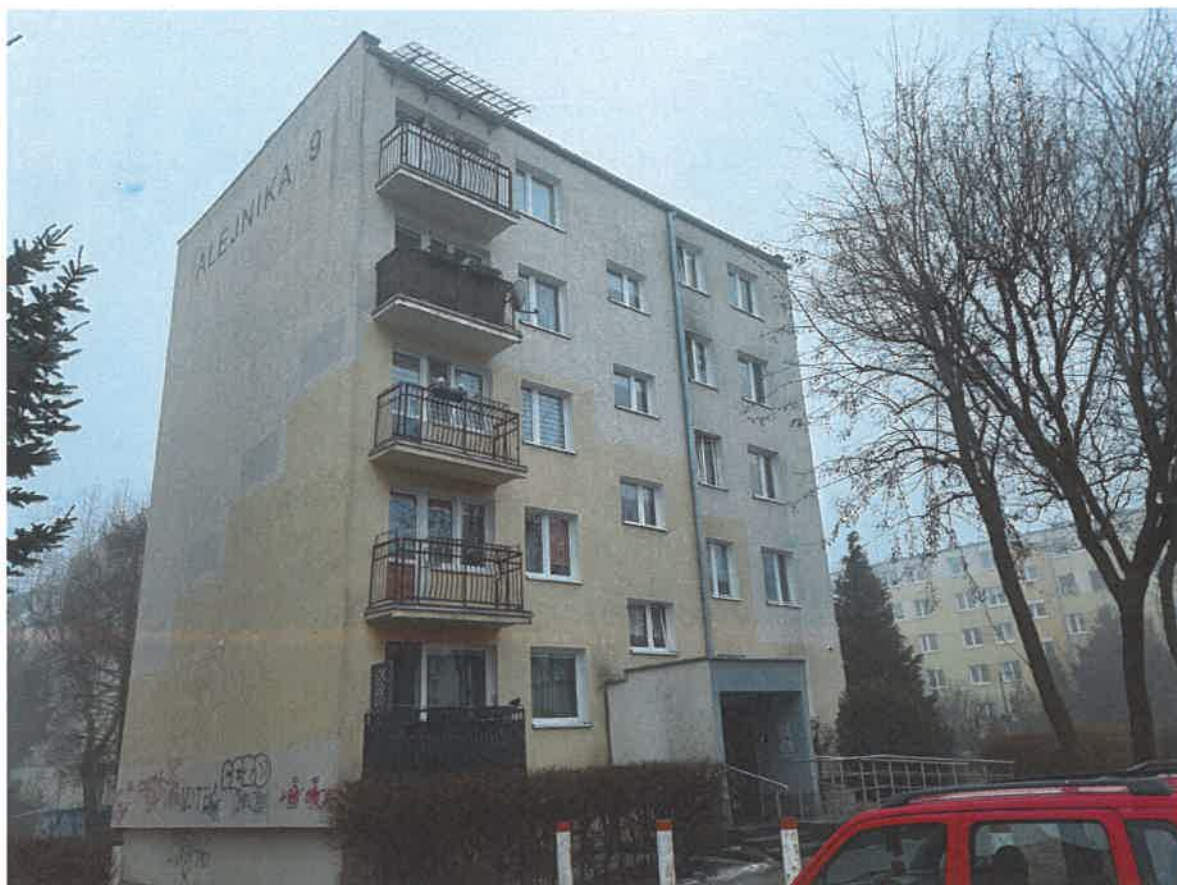
Zdj.4. Elewacje budynku od strony zachodniej.
