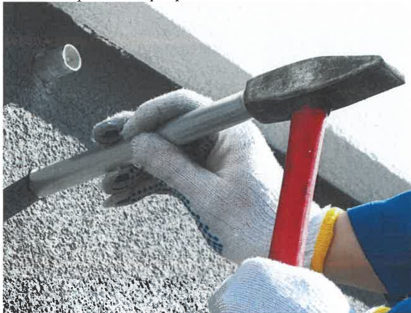
Zdj.13. Montaż tulei dystansowej.
