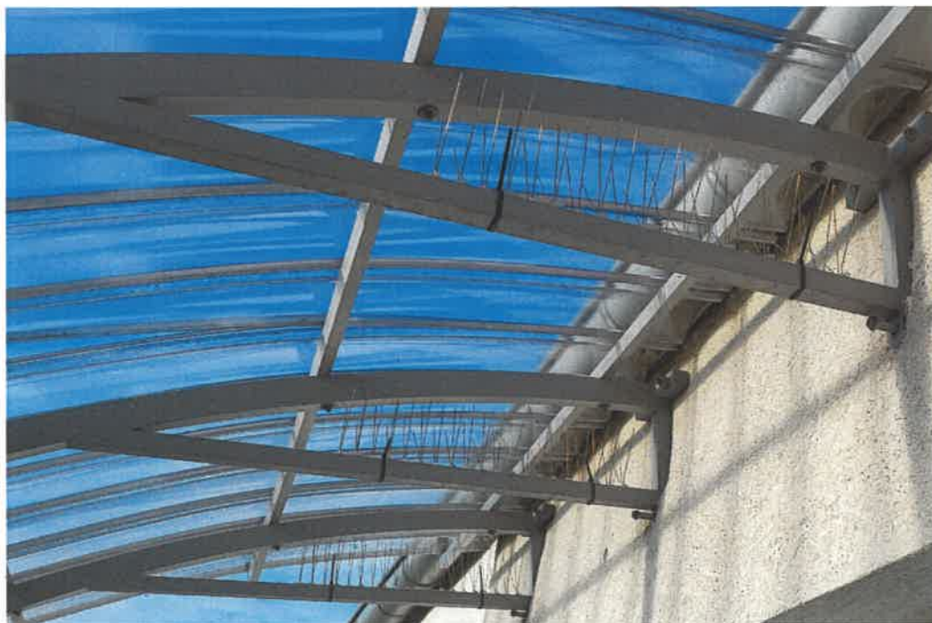
Zdj.6. Uszkodzenia elewacji powstałe wyniku zapadnięcia się w warstwie tynku cienkowarstwowego oraz izolacji termicznej.
