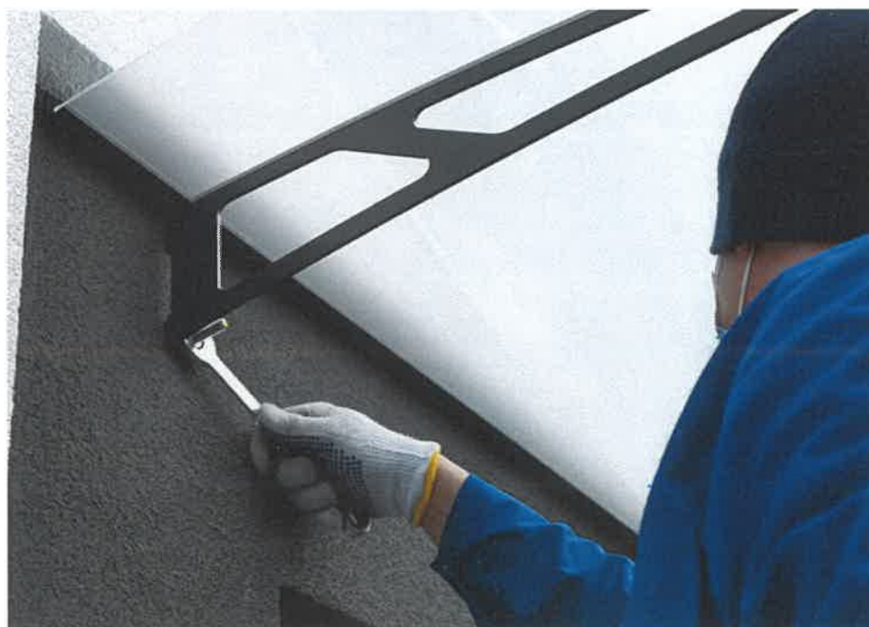
Zdj.16. Przykręcanie daszku opartego na konstrukcji nośnej budynku.
