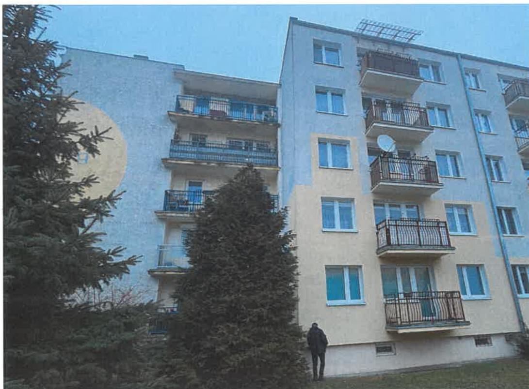
Zdj.1. Elewacje budynku od strony południowej.
