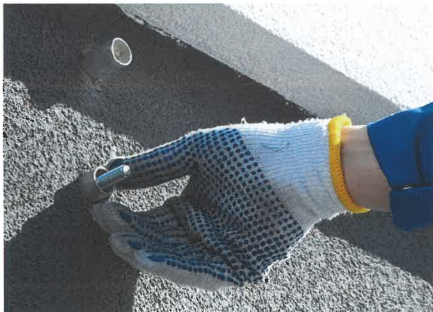
Zdj.14. Montaż kotwy oraz tulei dystansowej.
