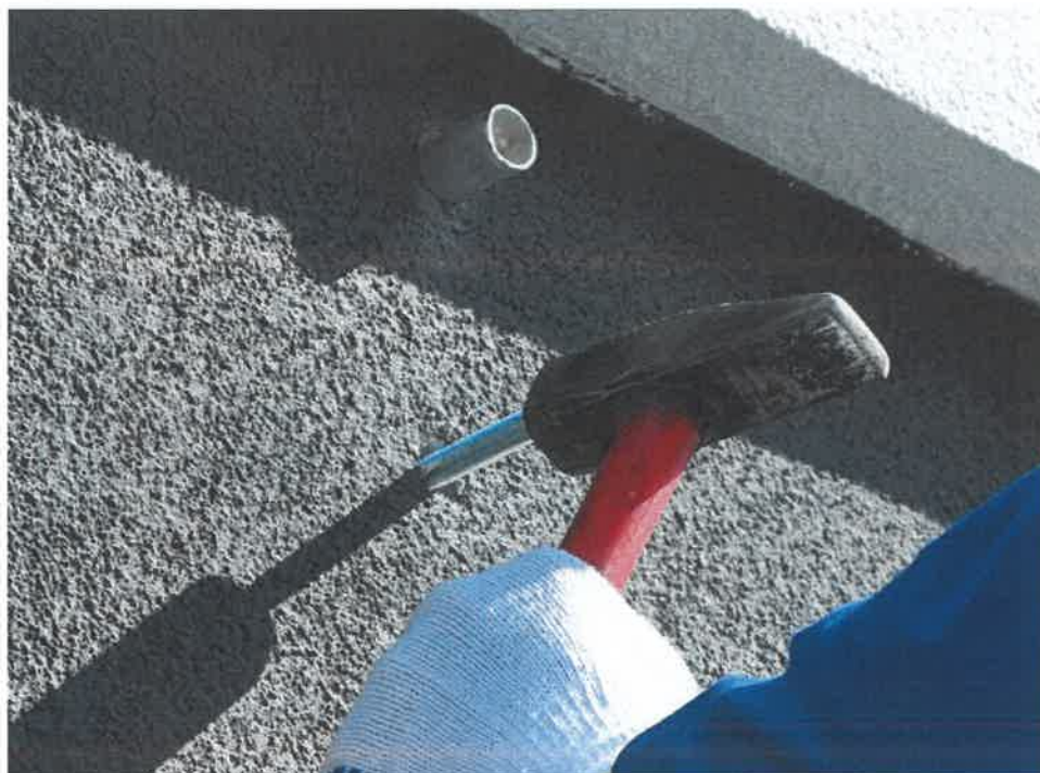
Zdj.15. Montaż kotwy oraz tulei dystansowej cd.
